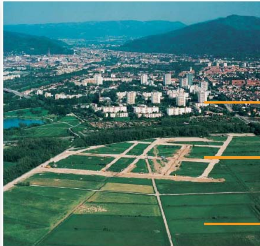
Freiburg-Weingarten. Sozialer Wohnungsbau mit nahezu 80% Belegungsrecht durch die Stadt
