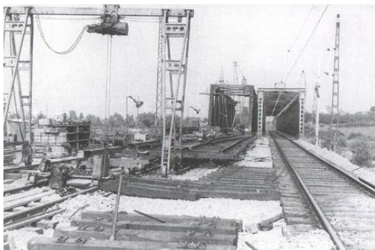
Bau der zweiten Bregenzerachbrücke, 1960
