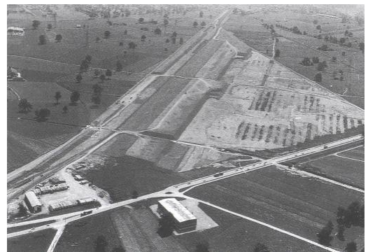
Baubeginn Güterbahnhof Wolfurt, 1969
