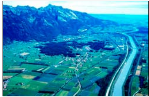
Abb. 1 Alpenrheintal bei Sennwald Der gestreckte Alpenrhein und die flankierende Nationalstraße N 13 richten das Alpenrheintal als Durchgangstal aus, prägend wird das Auftrennen und das Beschleunigen.
