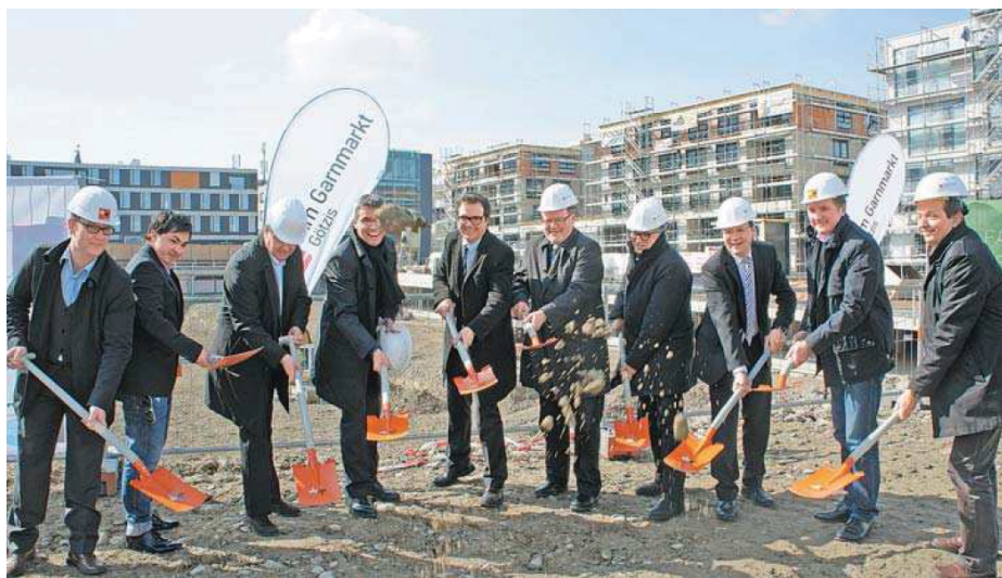
Der Spatenstich zur dritten Bauphase läutet eine neue Ära des 87 Millionen Euro-Projektes ein.
