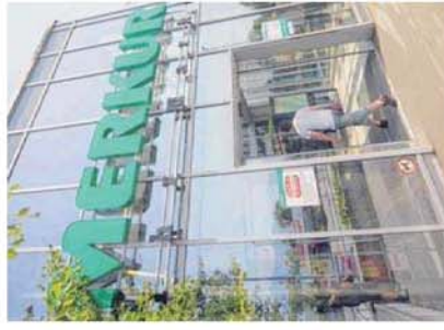
Wird völlig erneuert: der Rankweiler Merkur-Markt. FOTO: VN/BH
