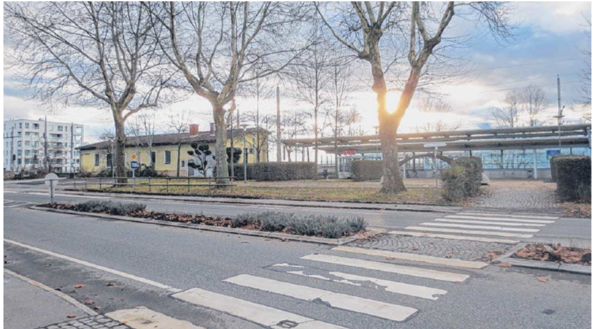
Das alte Bahnhofsgebäude wird abgerissen und macht so Platz für den geplanten Neubau.
