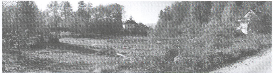
Der Standort in der Badstraße nach den durchgeführten Abbruch- und Rodungsarbeiten.
